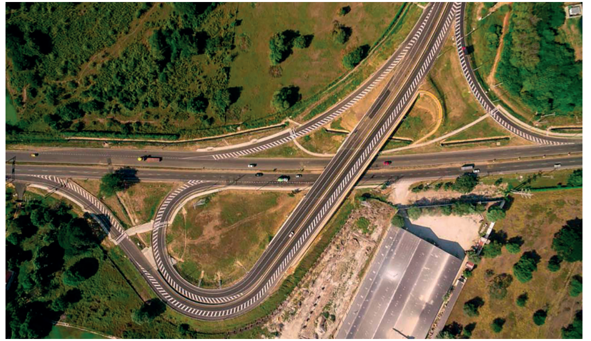
Foto: Agencia Nacional de Infraestructura.
